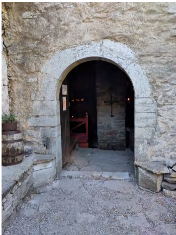
Bild 17. Kapitelhuset i Visby. Den återskapade portalen på östra långsidan. Portalens läge lokaliserades 1943 genom att tröskeln grävdes fram. Inga spår har däremot påträffats efter någon ursprunglig omfattning (ATA dnr 634/44). Foto 2022 Linda Qviström.
