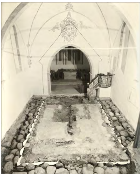
Bild 16-17. Till vänster vy över långhuset i Silte och utgrävningen av stavkyrkogrunden. I korväggen syns konturen av stavkyrkans tak. Till höger en rekonstruktionsskiss av mötet mellan vägg och grund av Gustaf Trotzig.
